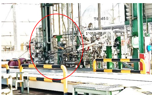
รูปที่ 2.1-32 เจ้าหน้าที่ตรวจสอบการรั่วซึม ด้วยเครื่อง Gas Detector
